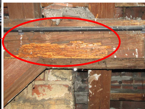
Fot. 3. Platew częściowo spróchniała – porażona przez owady – techniczne szkodniki drewna
